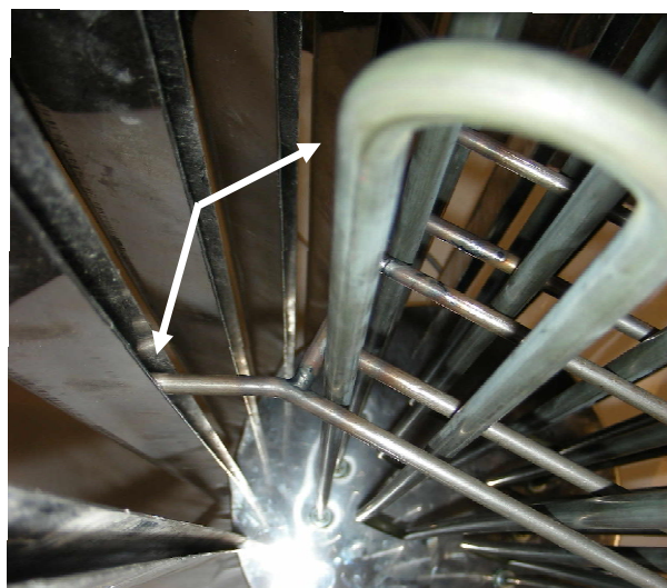
Immagine 4 Installazione del supporto per gli elementi riscaldanti
